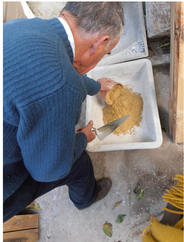
Figura 6. Preparação de argamassa de cal.
