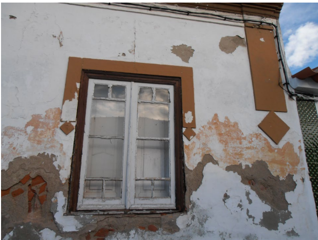
Figura 1. Anomalias devidas ao uso de materiais incompatíveis.
