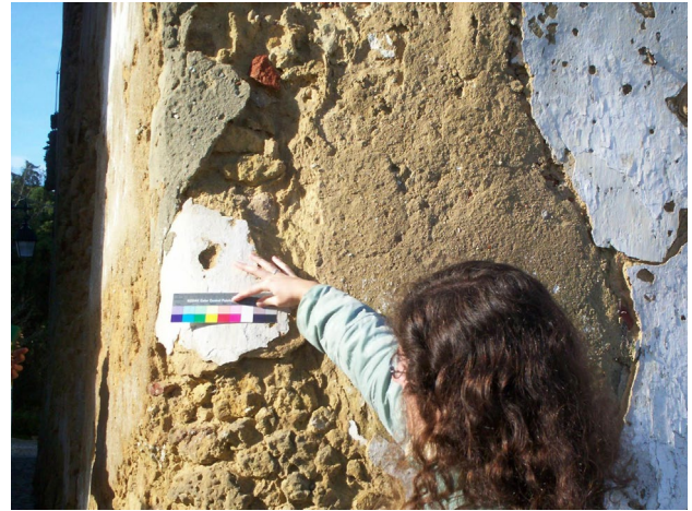
Figura 8. Exame de reboco de pintura com cal.
